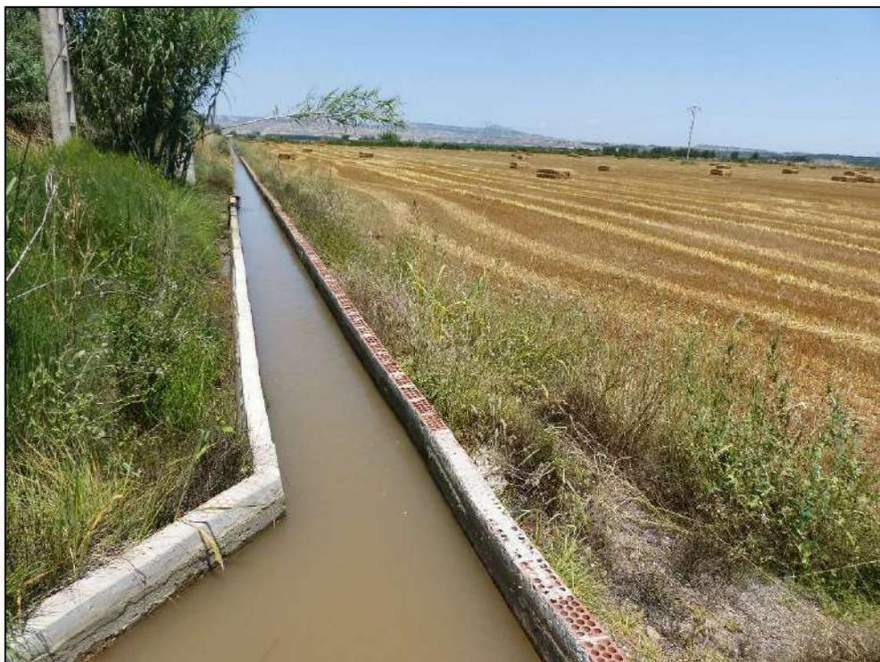
**Ilustración 55.** Trazado del río Huecha en su parte más cercana al casco urbano de la localidad. En concreto, circula en dirección – sentido – norte, en la zona próxima a la calle Ribera de Navarra. En este punto, la cota de los márgenes del río sobre el propio cauce es muy pequeña, por lo que los desbordamientos suceden con relativa facilidad, afectado cuando esto sucede a las acequias y huertos próximos.
