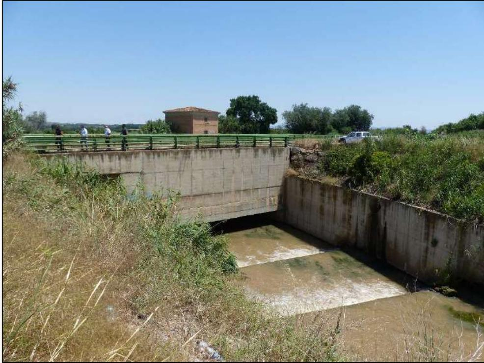
**Ilustración 54.** Encauzamiento del río Huecha, que circula bajo el canal Imperial de Aragón. Tras salvar este punto, el Huecha circula ya hasta su confluencia con el Ebro, ya fuera del término municipal de Cortes.
