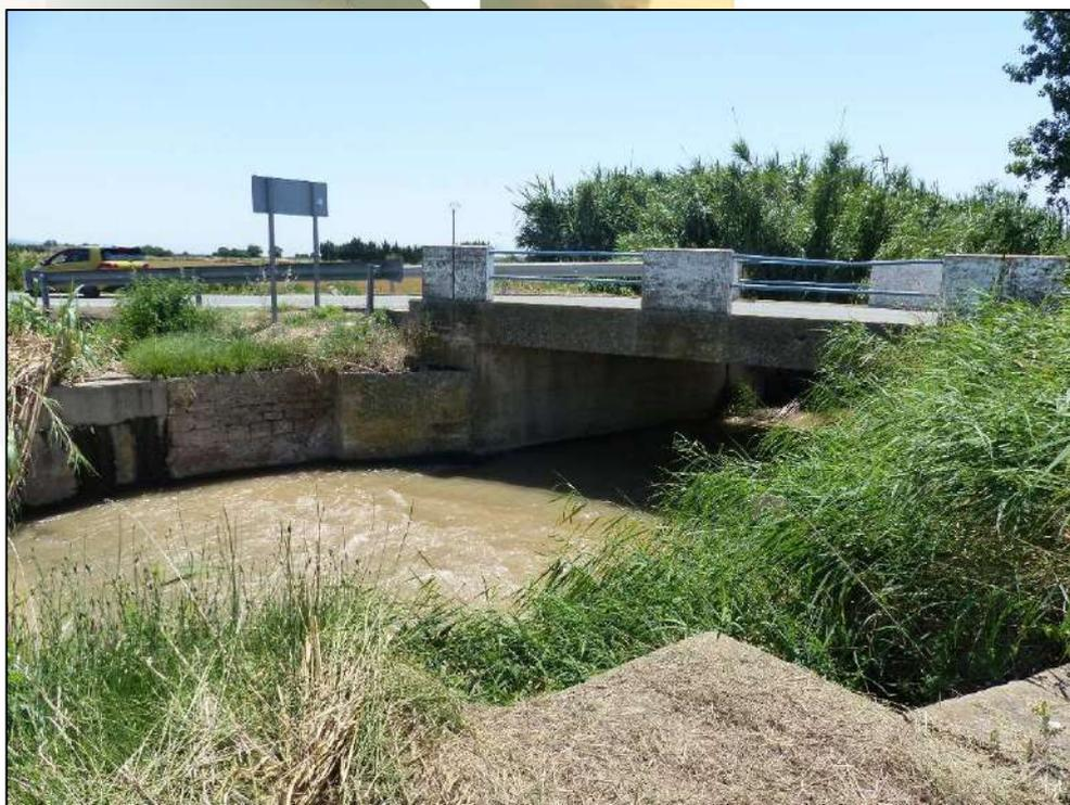
**Ilustración 51.** Puente de la carretera NA-5221 Cortes – Novillas sobre el río Huecha, justo ya aguas abajo del casco urbano de Cortes. Los desbordamientos en este punto provocan que la inundación circule hacia el casco urbano, ya que como se puede observar en la segunda foto, el casco urbano se encuentra a una cota algo menor.
