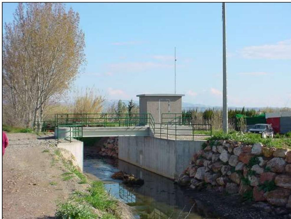
**Ilustración 7.** Fotografía de la estación de aforo del río Huecha situada en el término municipal de Cortes. Imagen obtenida de la página web del SAIH de la Confederación del Ebro.
