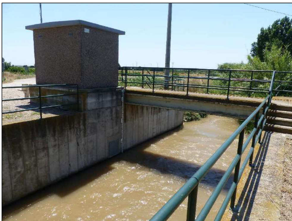
Ilustración 52. Vista de la estación de aforo con comunicación de datos en tiempo real que la CHE tiene en Cortes, en el río Huecha.
