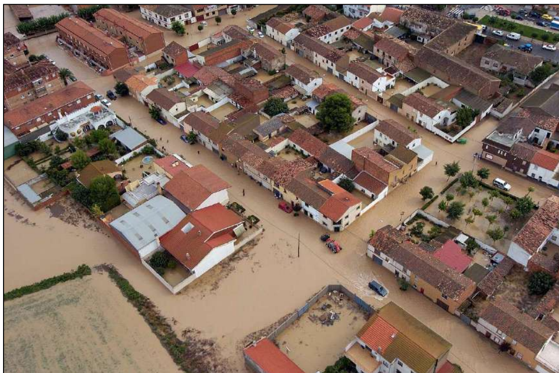
Ilustración 21. Imagen tomada tras las inundaciones de 2004 donde se puede observar con claridad la magnitud de la riada, que afectó a gran parte del casco urbano de Cortes.
