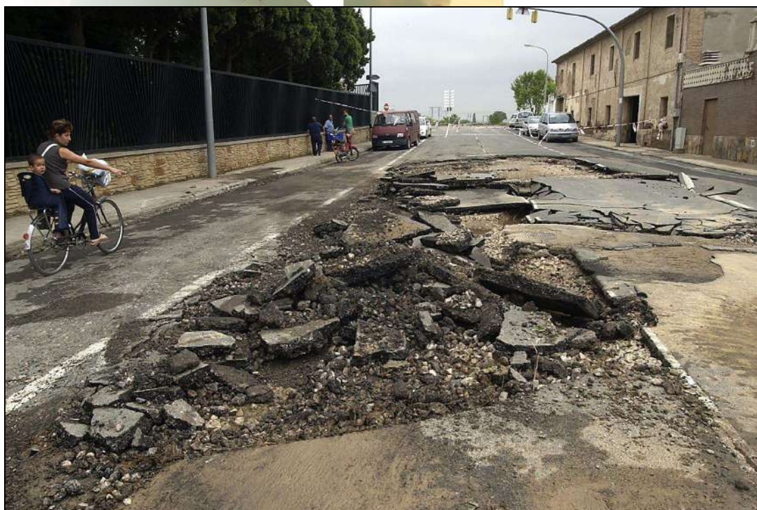
Ilustración 25. La riada causó importantes daños tanto en vehículos como en las infraestructuras y vías de comunicación de la localidad. Los daños incluyeron fallos en el tendido eléctrico que dejaron sin luz a la localidad durante la tormenta
