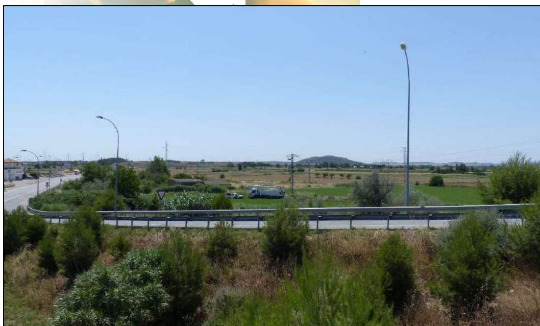
Ilustración 31. Zona del punto de desbordamiento [1] , mostrada en la imagen de la página anterior. Vista de los campos de cultivo, prácticamente llanos, que conducen la posible inundación hacia la barrera longitudinal que supone la carretera N-232.
