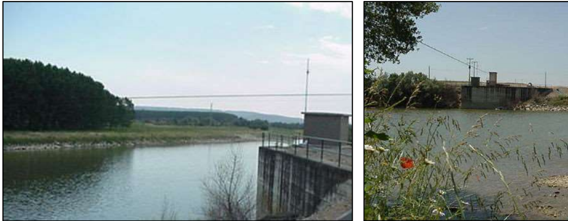
Ilustración 9. Fotografías de la estación de aforo del río Ebro situada en el término municipal de Castejón. Imágenes obtenidas de la página web del SAIH de la Confederación del Ebro.
