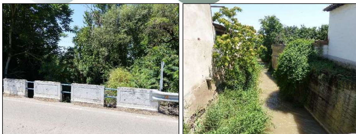
Ilustración 30. Puente del Huecha, justo en la entrada en territorio navarro, antes de acercarse al casco urbano de Cortes.
