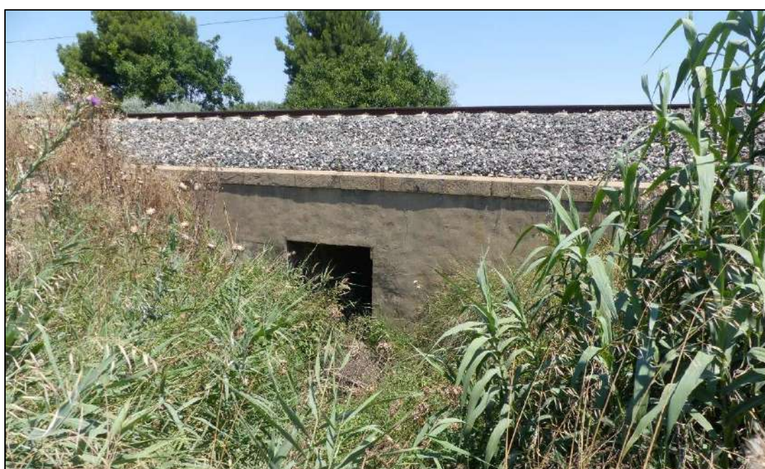
Ilustración 29. Permeabilización disponible bajo las vías del tren, cerca del puente de la carretera NA-5222, que da acceso de Cortes a la N-232, sobre dichas vías.
