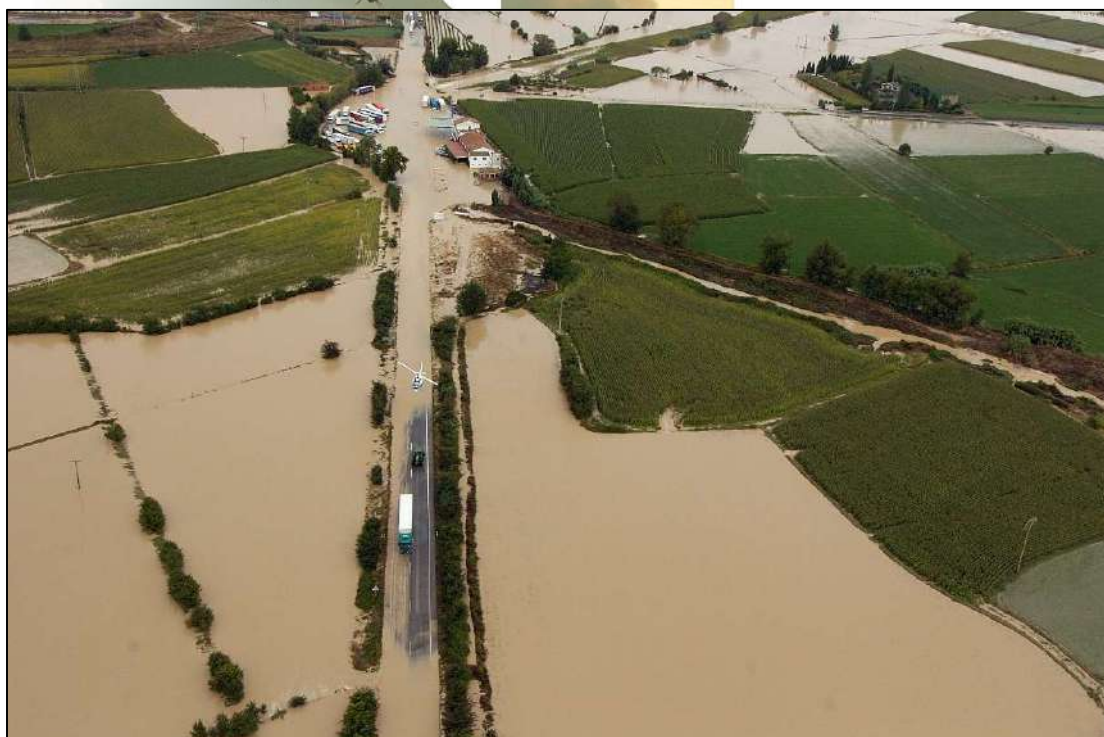
Ilustración 22. Imagen aérea de la grave inundación que afectó a la circulación de vías tan importantes como la carretera N-132. Llama la atención la gravedad de la inundación en este punto, ya que se encuentra a una distancia significativa del cauce del Huecha. La zona mostrada coincide con el límite territorial de Navarra.
