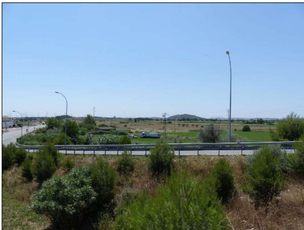
Ilustración 47. Puente sobre la carretera N-232. Cruce/intersección con la NA-5222. Vistas de la cuenca del río Hueca, procedente del término municipal de Mallén (Aragón). Zonas comúnmente inundadas al producirse desbordamientos del Huecha en su margen izquierdo.
