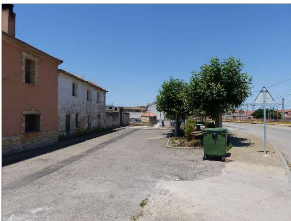
Ilustración 50. Vista del paso de la carretera NA-5200 Cortes – Mallén bajo las vías del tren del trazado Zaragoza-Altsasu/Alsasua. En la foto inferior se muestra la caseta donde se encuentran los bombeos para evitar la inundación del paso bajo las vías del tren.
