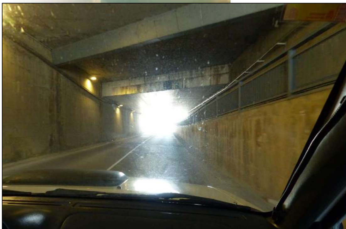
Ilustración 35. Paso de la carretera NA-5200 que une Cortes con Mallen, bajo las vías del tren discurre por el término municipal de Cortes.
