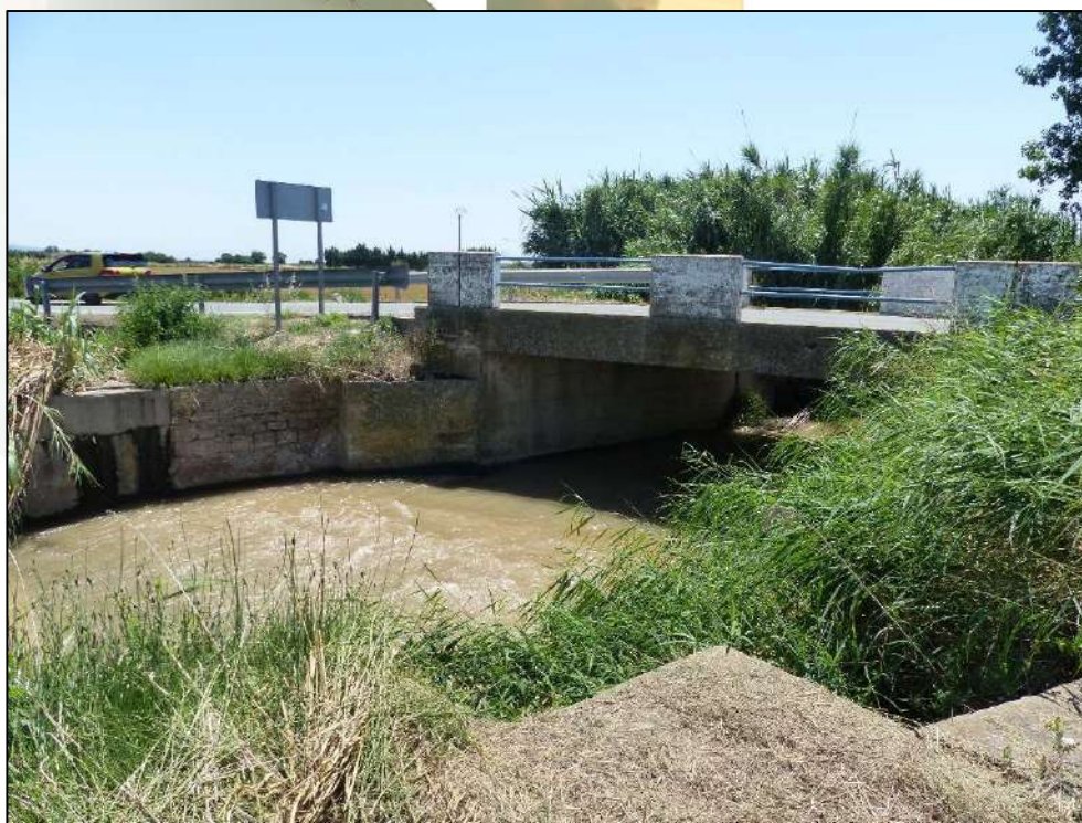
Ilustración 51. Puente de la carretera NA-5221 Cortes – Novillas sobre el río Huecha, justo ya aguas abajo del casco urbano de Cortes. Los desbordamientos en este punto provocan que la inundación circule hacia el casco urbano, ya que como se puede observar en la segunda foto, el casco urbano se encuentra a una cota algo menor.
